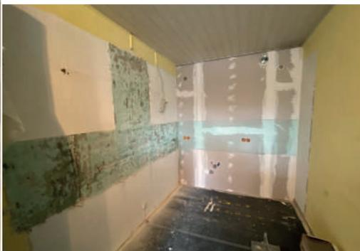
**Tag 5** Abschluss Trockenbauarbeiten inklusive Spachtelarbeiten - Vorbereitungen für das Anbringen der Fliesenspiegel
