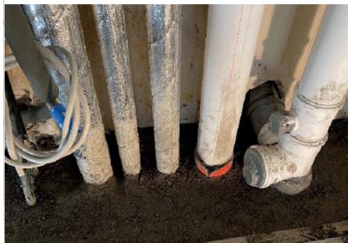
**Tag 3** Isolierung der neuen Steigestränge, Anbindung der neuen Elektroleitung an den Bestand, Einbau der Brandschottungen in allen Geschossen, ausbetonieren der Deckendurchbrüche
