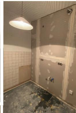
**Tag 4** Einbau der Trockenbauunterkonstruktion, Beginn mit dem Schließen der Wände inklusive erstes Spachteln
