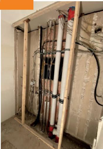
**Tag 2** Öffnung der Vorwand, Demontage aller alten Installationsleitungen und Erneuerung der Wasser- und Abwasserleitung
