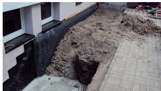
während der Baumaßnahme
