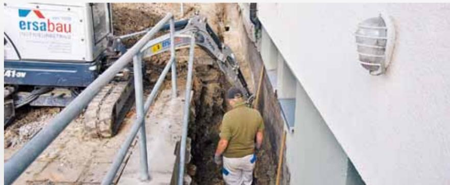
schnitt umfasst dabei die Trockenlegung des Gebäudes. Dies beinhaltet zum einen die Aufschachtung und Bauwerksabdichtung und zum anderen die Verlegung einer Drainage, um das Wasser direkt ableiten zu können.
